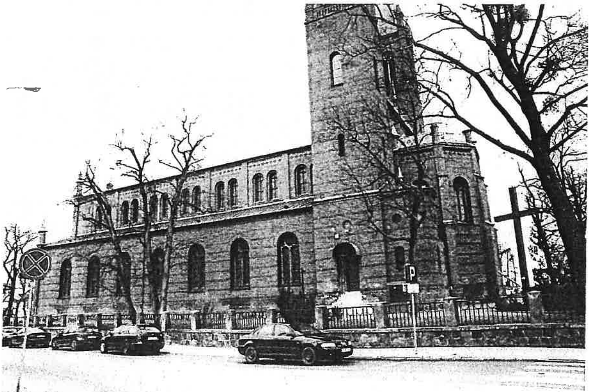
Kościół p.w. św. Trójcy, widok ogólny od strony południowo-wschodniej
